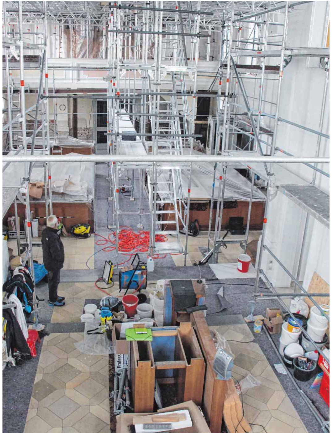
Die Wallfahrtskirche am Gottesberg ist derzeit noch eine große Baustelle.
